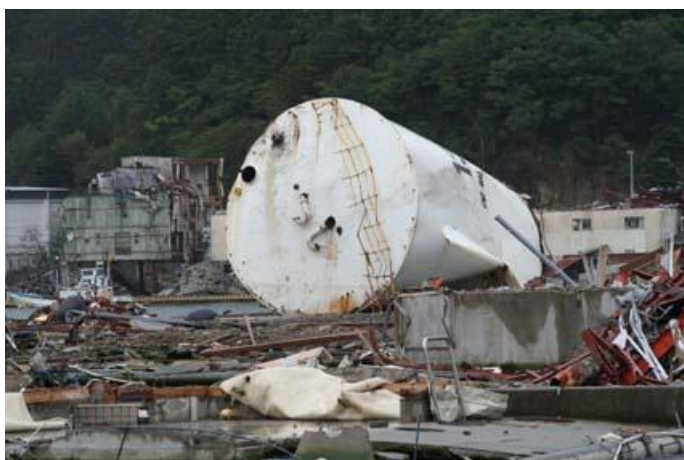
◇流され転がったタンク。周囲は魚が腐って硫化水素が充満している。
