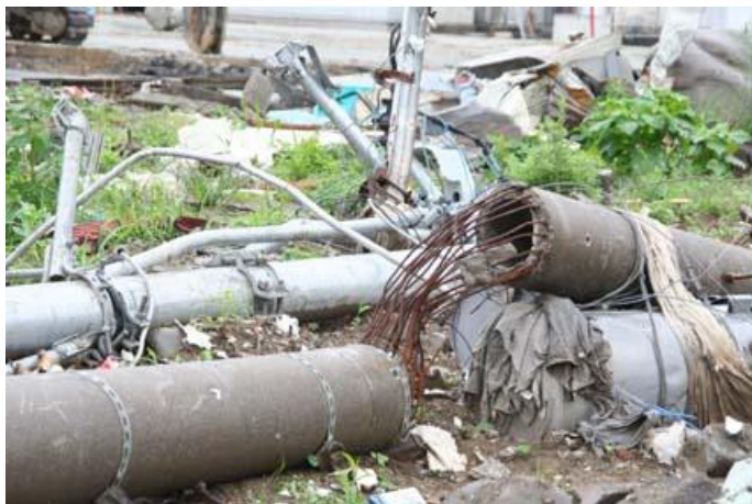
◇これだけ鉄筋が入っている電柱が、いとも簡単に折れてしまう。
